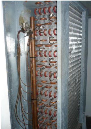
Evaporateur tunnel de congélation
