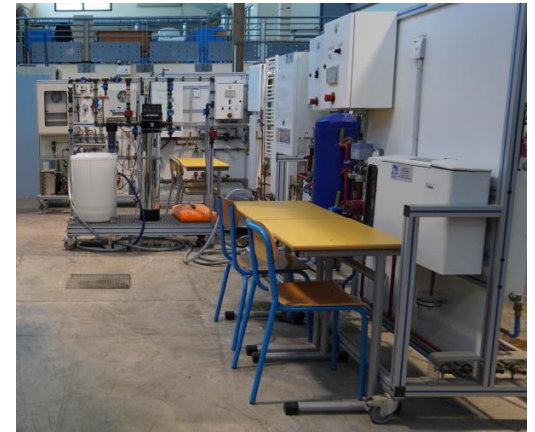
Bancs didactiques chaudière et traitement d'eau
